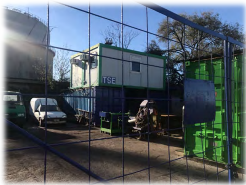
Ufficio e zona cantiere c/o Acciaierie Arvedi Trieste
