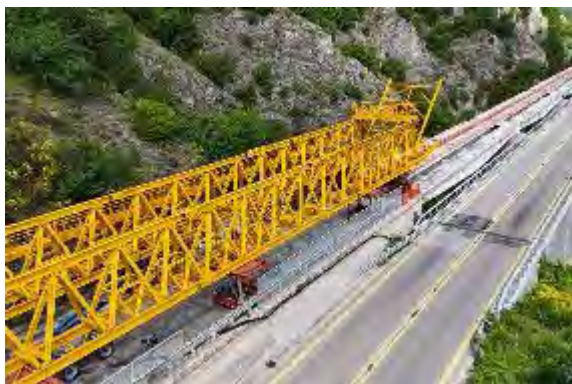
Viadotto Pietrastretta: sicurezza e innovazione lungo l'asse Salerno-Potenza
