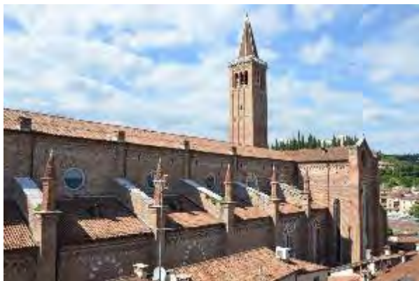
Intervento di restauro e messa in sicurezza sismica della Chiesa di Santa Anastasia a Verona
